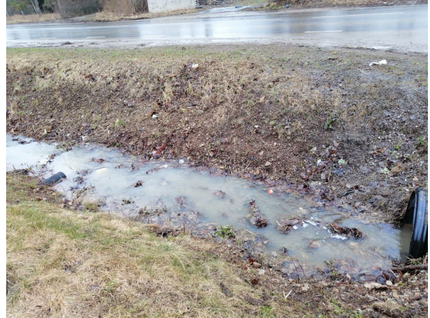
Foto 12. Sademeveetoru suubumine kraavi (kp 12.04.2021.a)
