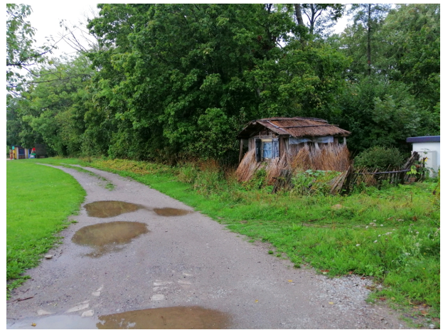
Foto 8. Vaade kinnistu lõunaosas asuvale kanakuudile ja alajaamale
